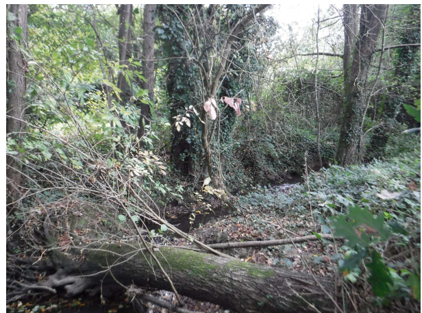
Premier radier aval à environ 12m de la sortie de buse
