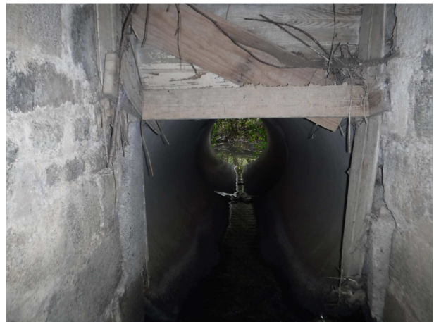
Jonction entre le pont et le busage
