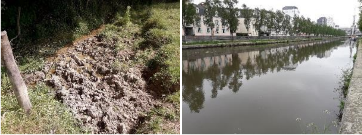
Figure 64 : Situations dégradées sur le territoire d'étude - Source : HARDY ENVIRONNEMENT
