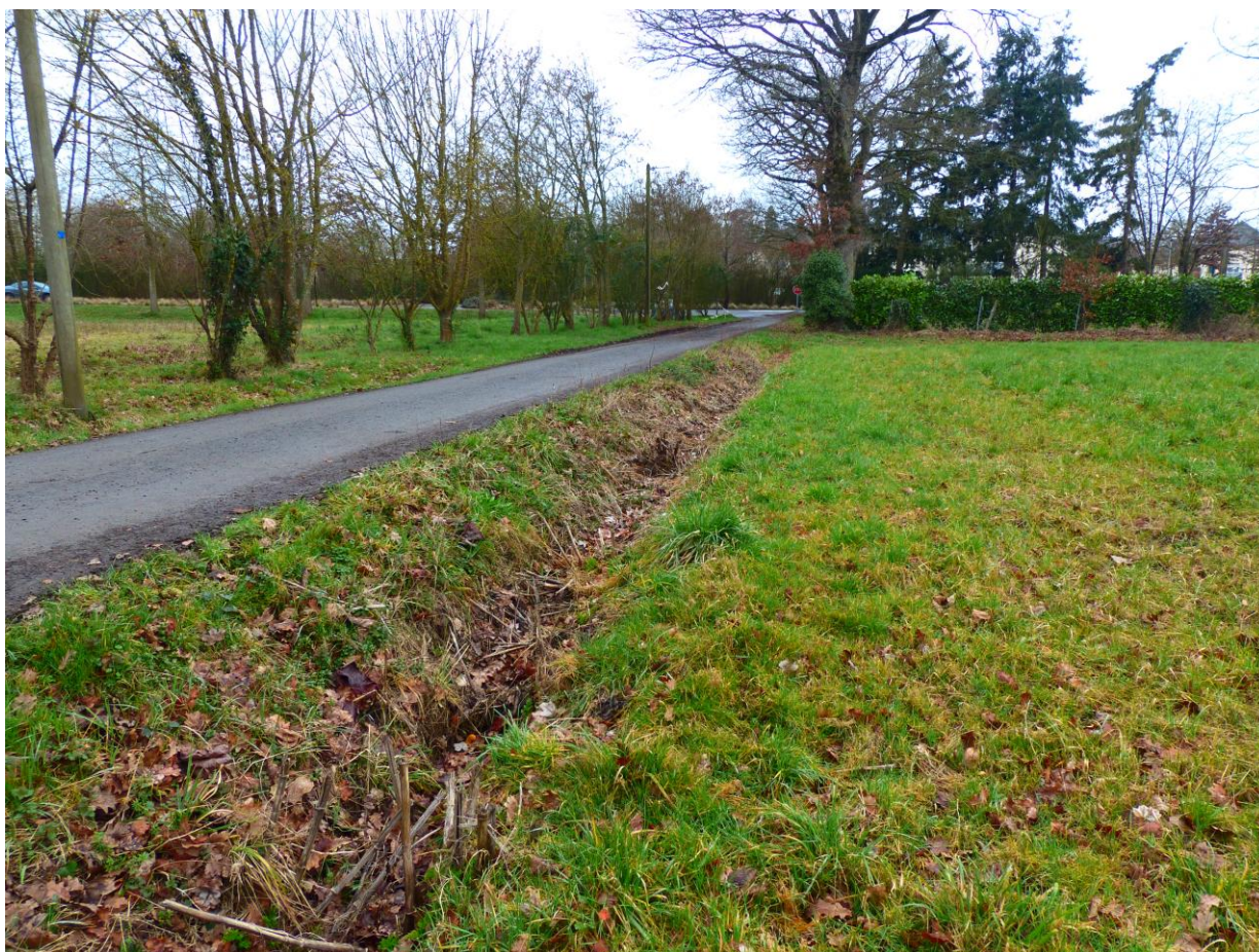
Photo 2: Le fossé existant sud de la zone d'étude
