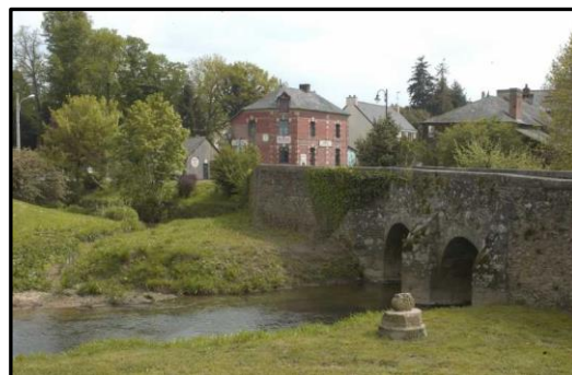
Pont de Pacé
