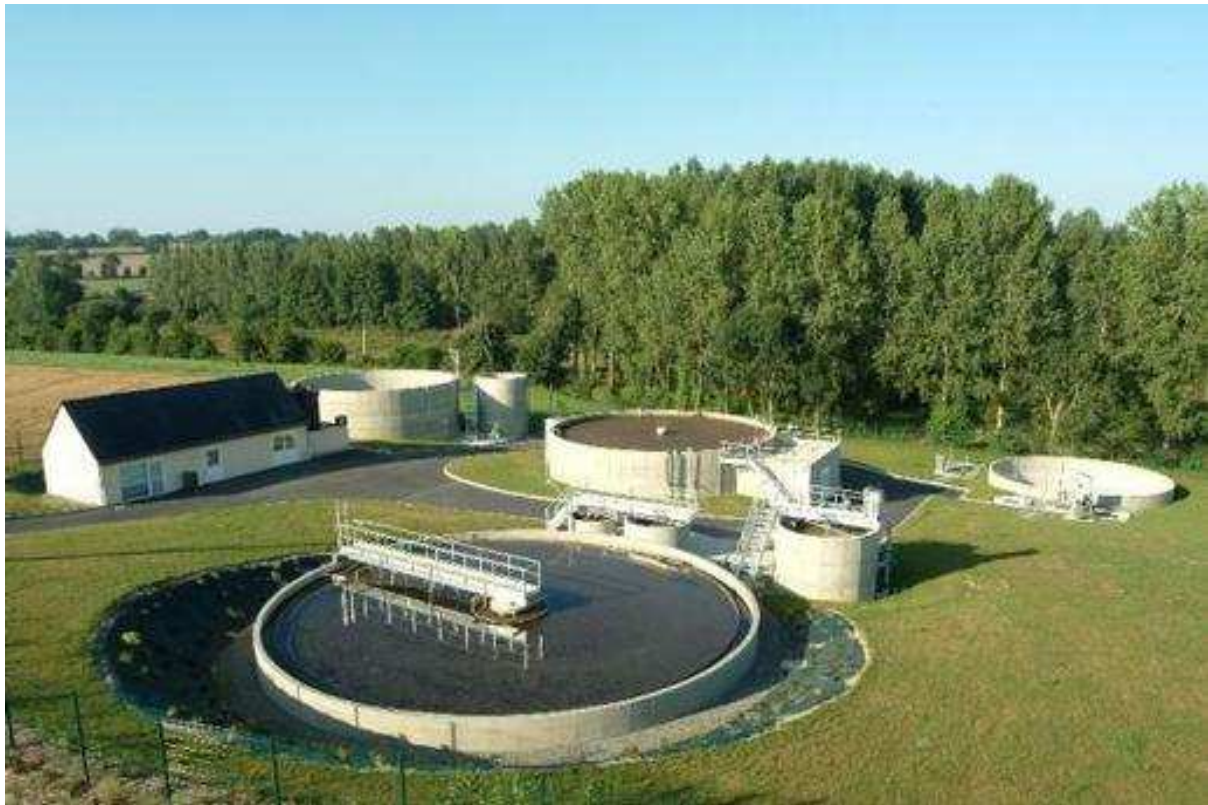
Figure 3 : Vue d'ensemble de la station d'épuration (2018)
