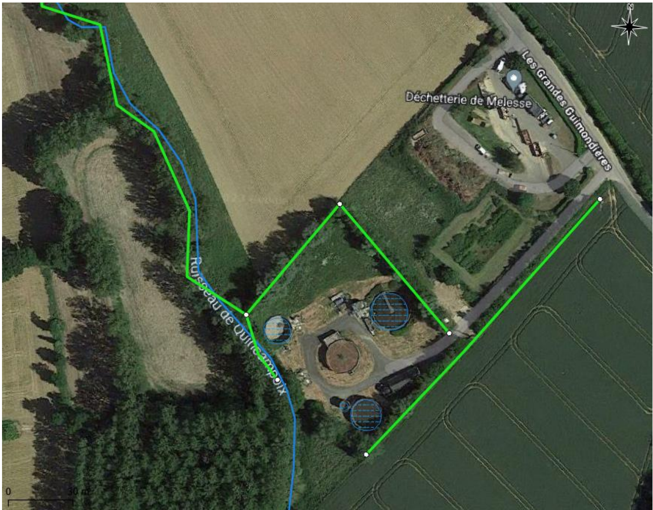
Figure 6 : Repérage des haies entourant le site d'épuration
